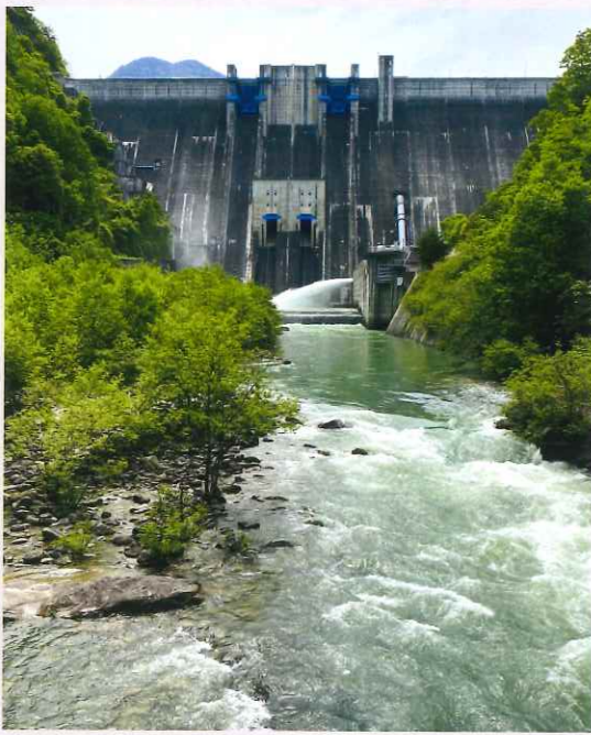
高さ107m、幅338m、東京ドーム23杯分の水を溜められる大町ダム
